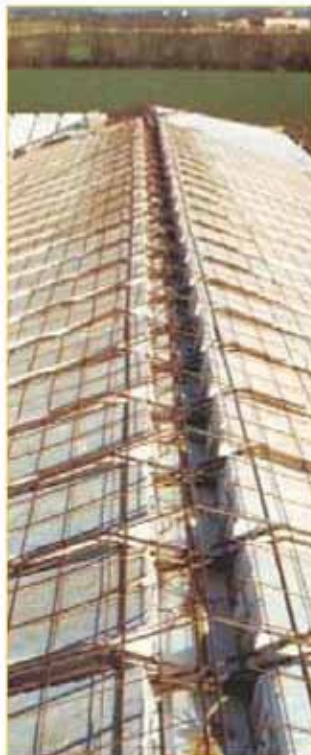
Roof System Ready to Pour
